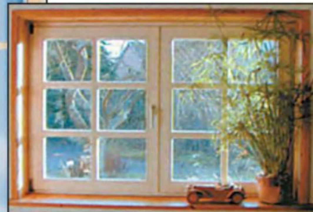
Вид на сад через окна с горбыльковыми рамками, установленными изнутри.
