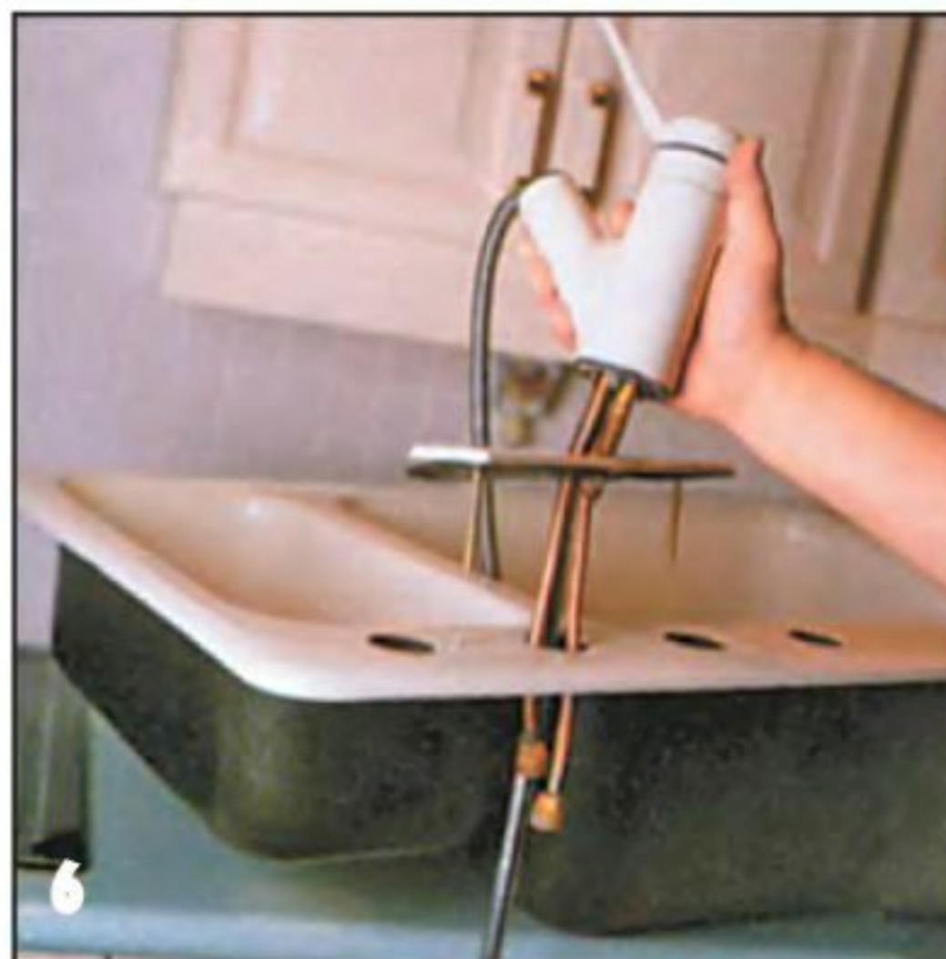
Демонтируют смеситель. Теперь всё готово для его разборки.
