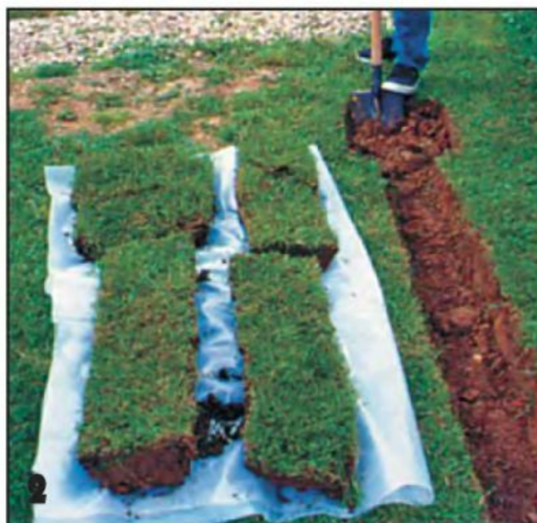
2 Снятый дёрн складывают на разостланную вдоль трассы плёнку. При необходимости его можно полить водой.
