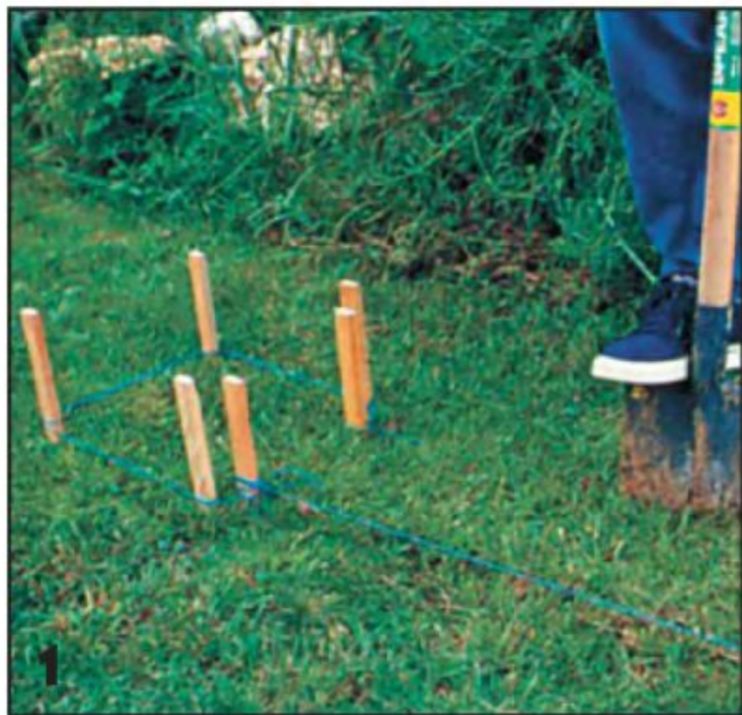
1 Сначала намечают место установки бетонного цоколя и трассу прокладки кабеля. По кабельной трассе штыковой лопатой на глубину 10 см снимают дёрн.
