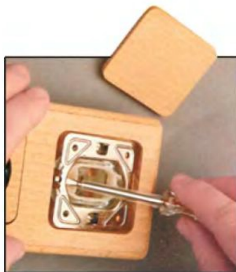
Снять промежуточную пластину можно отвёрткой.
