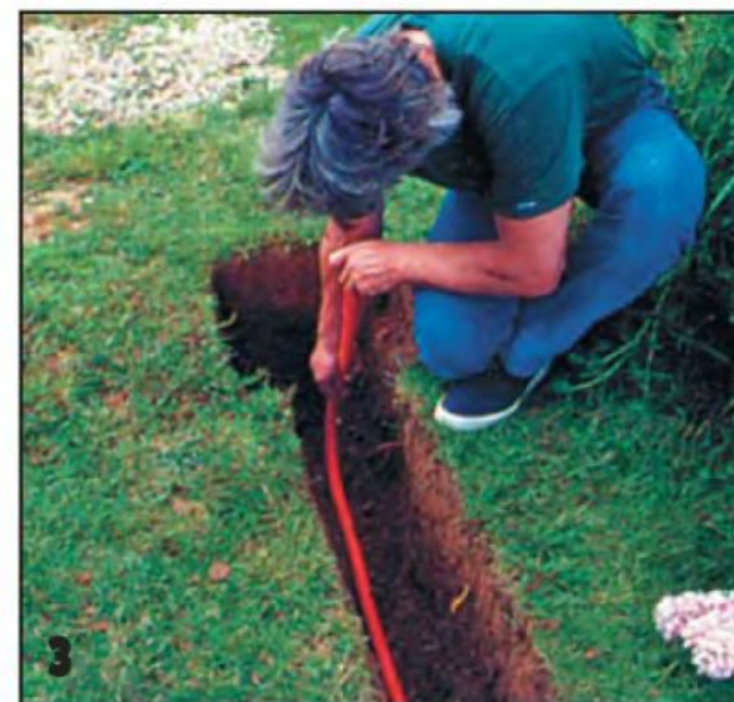
3 Вынув грунт на глубину 60 см, в траншею кладут пустую трубку для прокладки электропроводки.
