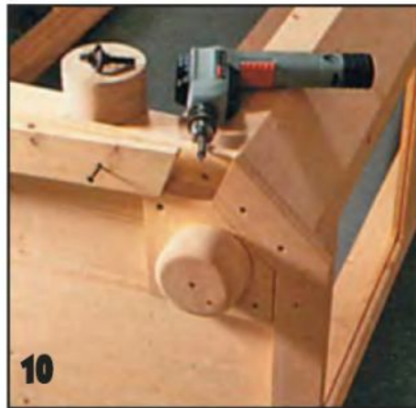
10 Клееные ножки крепят к переходным деталям, а уже их — к дну шкафа.
