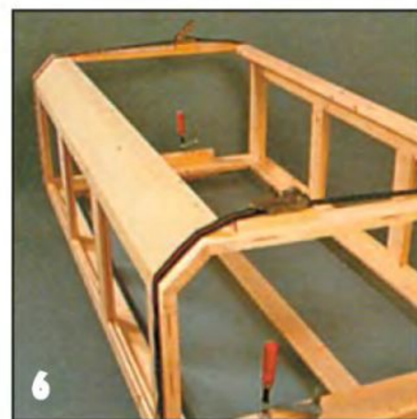
6 Сборка каркаса. Боковые рамы, задний элемент и передние поперечины склеивают друг с другом на шкантах.
