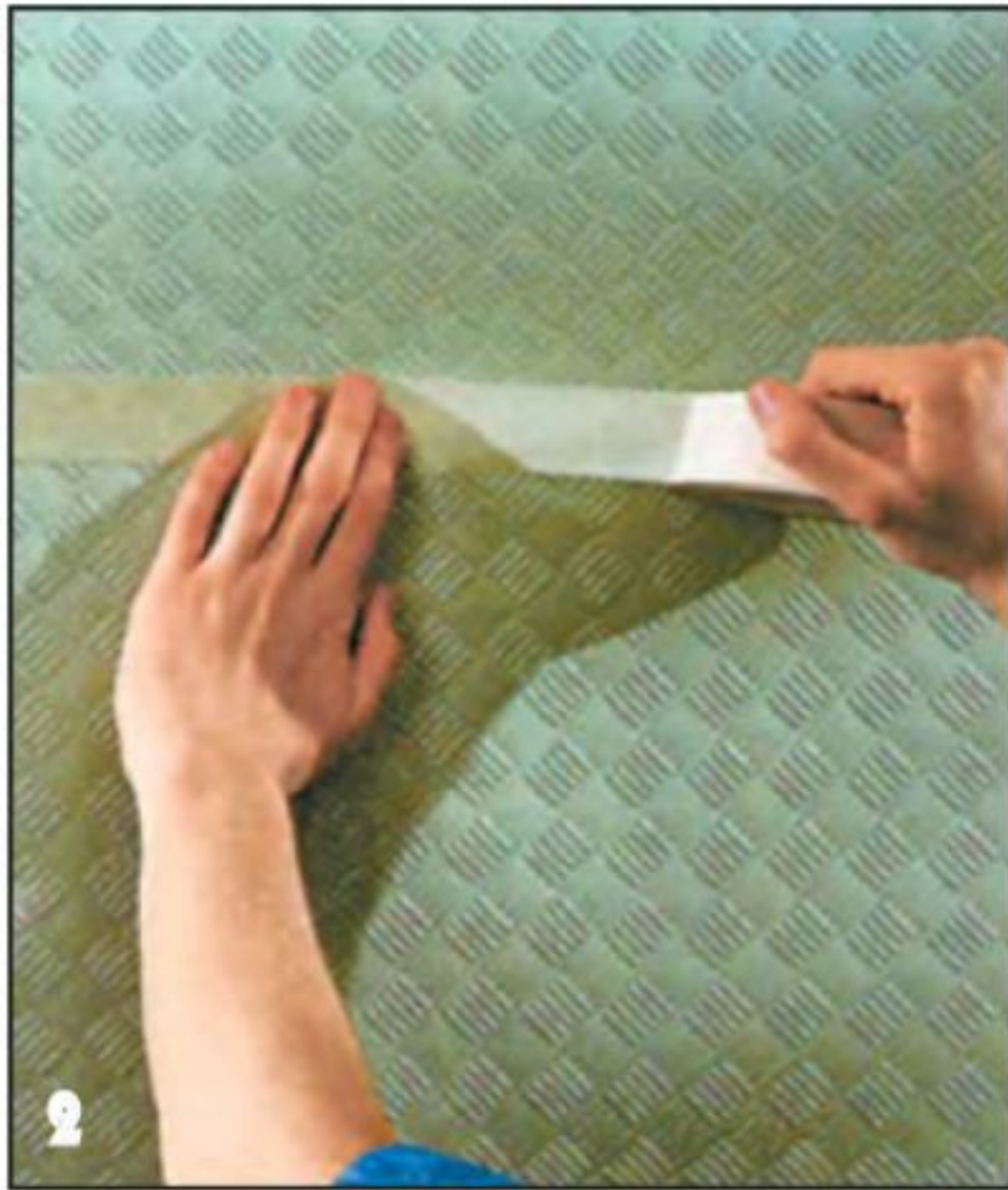
Предназначенный для отделки участок стены по периметру оклеивают малярной лентой.
