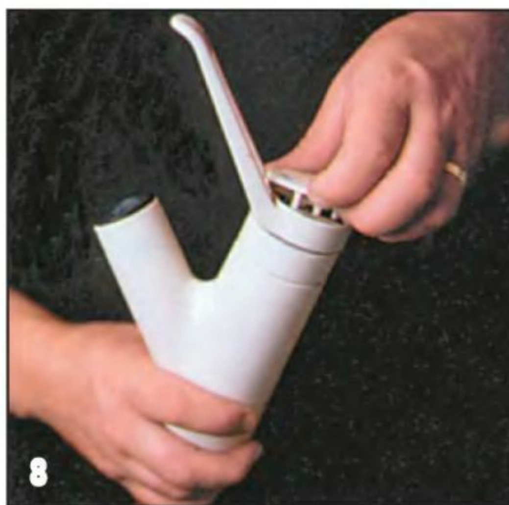
Осторожно удаляют крышку-накладку смесителя. Если накладку прихватило, её поддевают ножом.
