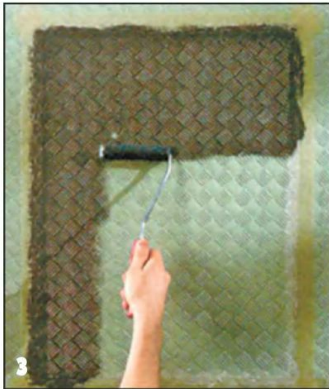
Хорошо размешав краску в ванночке, в неё окунают валик. Равномерно сняв излишки краски о края ванночки, краску аккуратно наносят на отделываемую поверхность.
